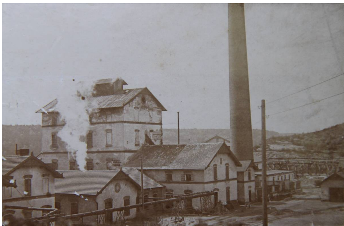
Obr. č. 6: Pohled na jámovou budovu Mayrau ze severovýchodu (foto z archivu skanzenu Mayrau). Je patrné, že lanovnice byly stále pod střechou a strojovna pro parní stroj Ringhoffer ještě nestojí, tzn. foto před rokem 1905. Na střeše je však patrná nástavba (pravděpodobně kvůli větrání).
