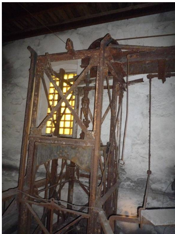
Obr. č. 21: Konstrukce samotížného výtahu.
