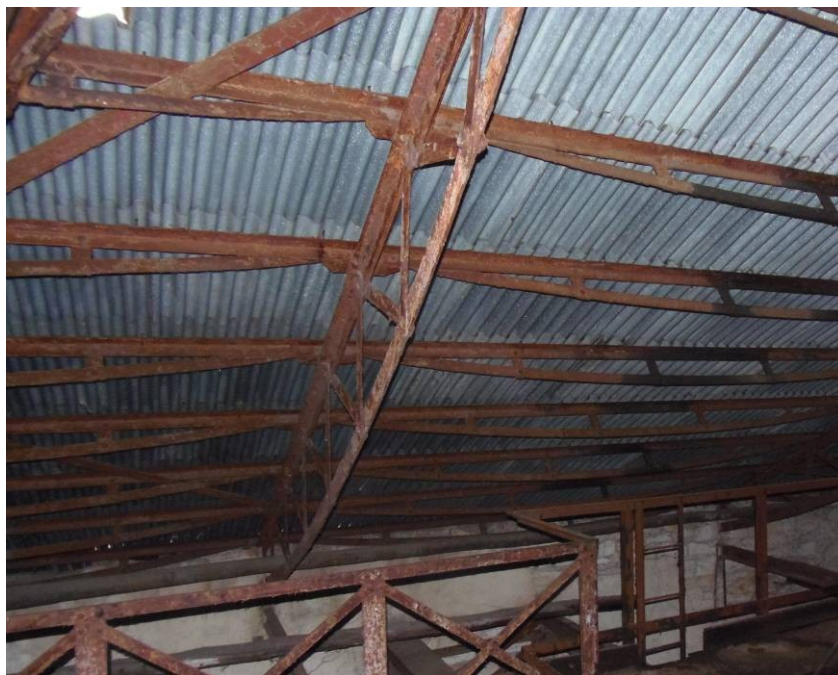
Obr. č. 15: Nosná konstrukce střechy.
