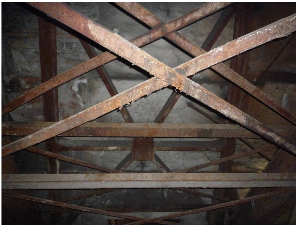
Obr. č. 13: Srovnání vzpěry z r. 1877 (v popředí, subtilní pásky) a přidané vzpěry z r. 1905 (v pozadí válcované profily).
