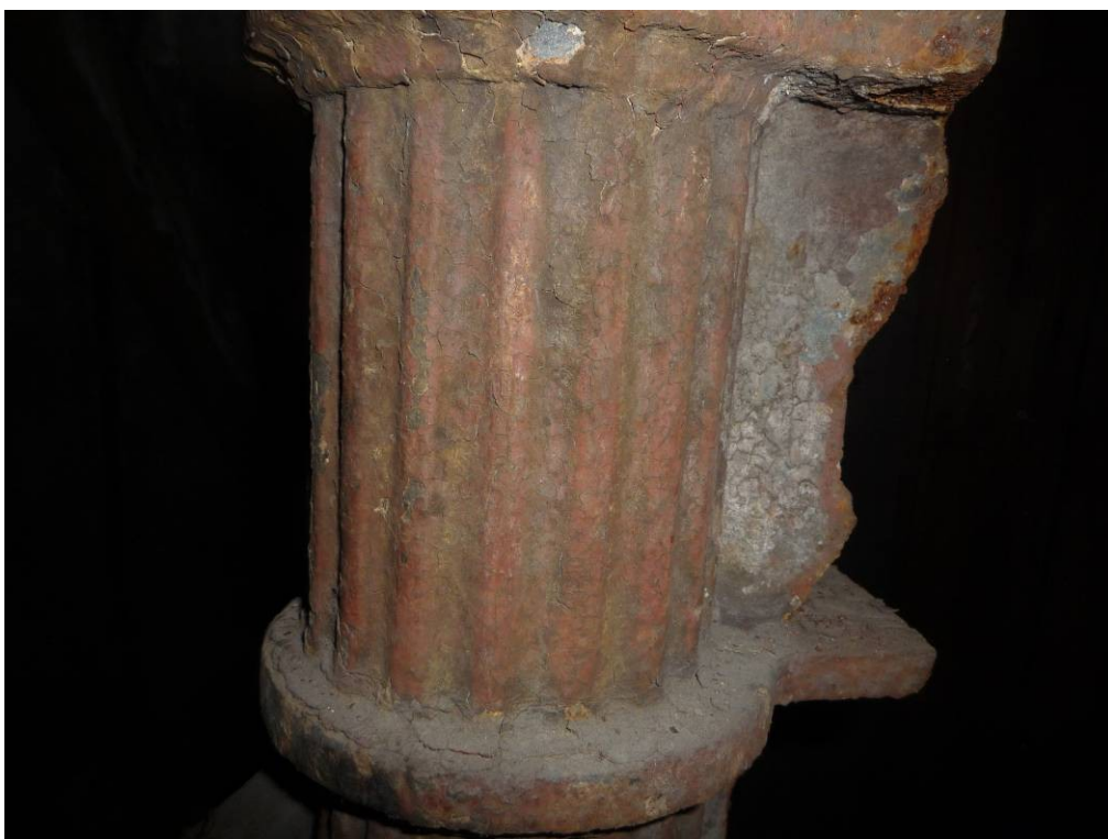
Obr. č. 8: Uražený litinový stupeň.
