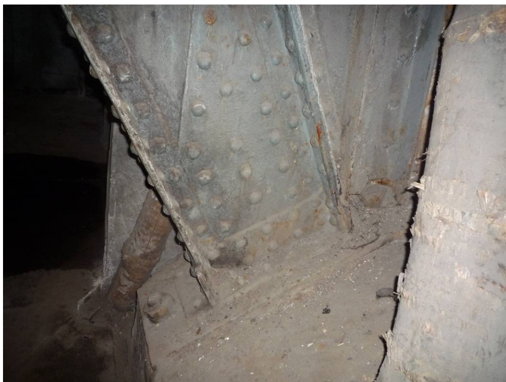
Obr. č. 10: Kotvení hlavní vzpěry těžní věže. Z detailu je zřejmé doplnění zadní vzpěry při zvyšování věže v r. 1905.
