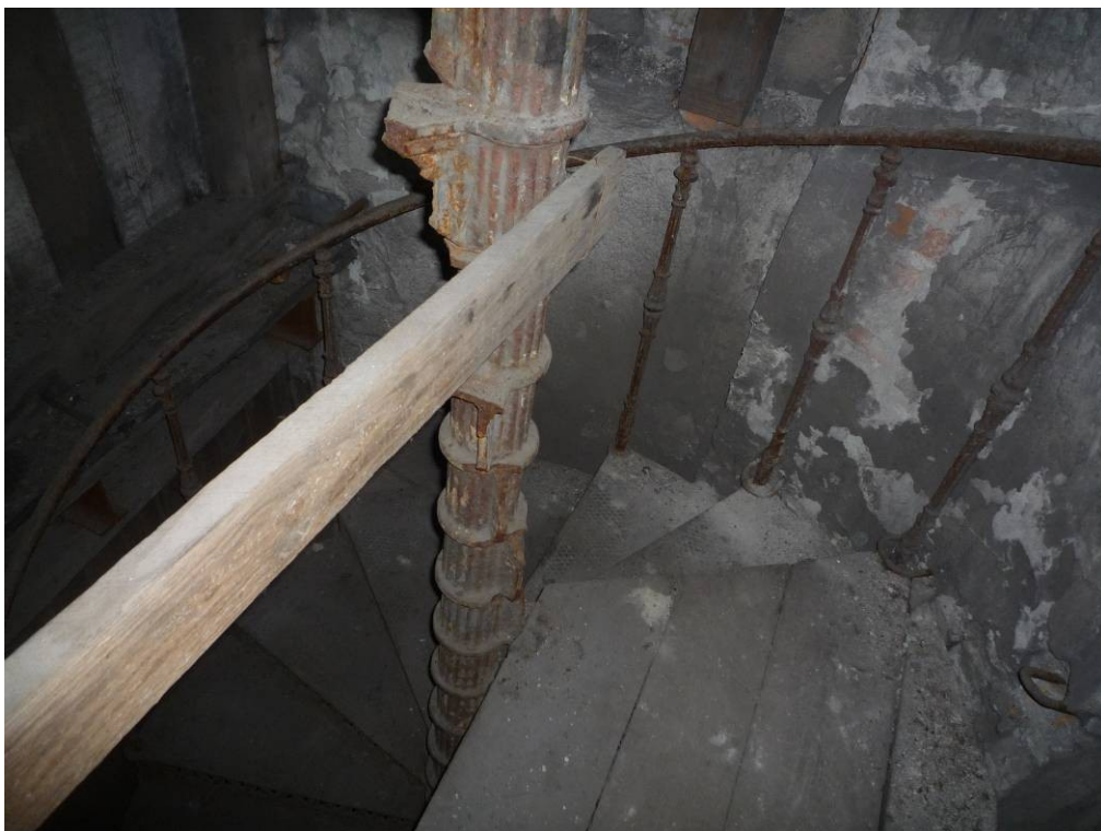
Obr. č. 7: Druhotně zřízený výstup z točitého schodiště.
